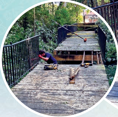
DURANTE LA REPARACIÓN
